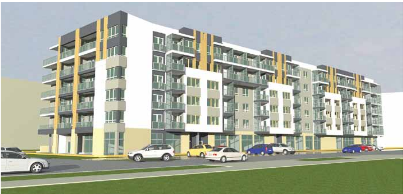
Koncepcja wielorodzinnego budynku mieszkalnego z usługami przy ul. Mołdawskiej - Plano Biuro Architektoniczne Sp. z o. o.
